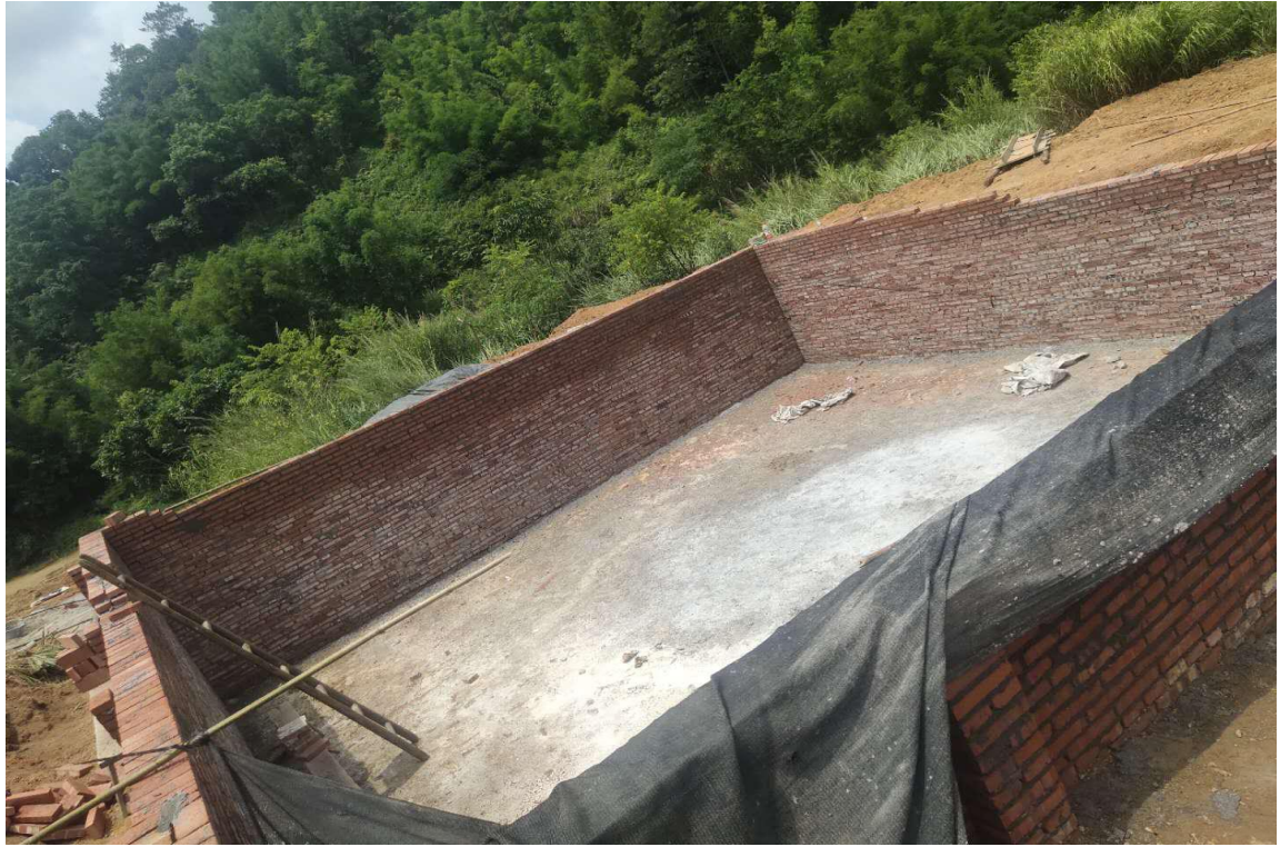
砖砌沉沙池现状
