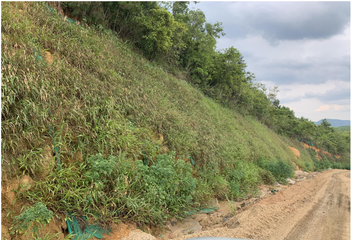
矿山道路区边坡现状
